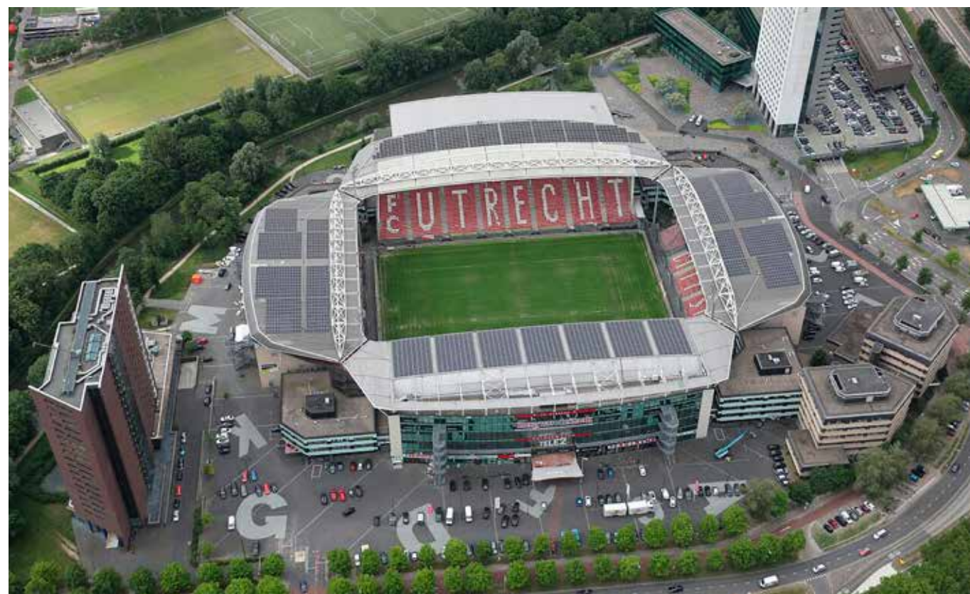
Eén van de grootste 'zonneparken' van Nederland bevindt zich op het dak van de tribunes van stadion Galgenwaard, een onderdeel van Galgenwaard Onroerend Goed B.V. en de thuisbasis van FC Utrecht.
